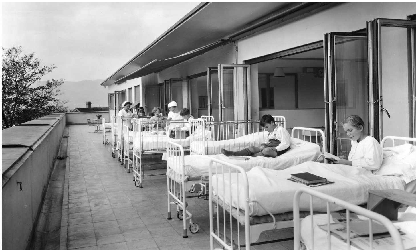
Abb. 18: Aufenthaltsraum Infektionshaus, Quelle: Baugeschichtliches Archiv, 1939
