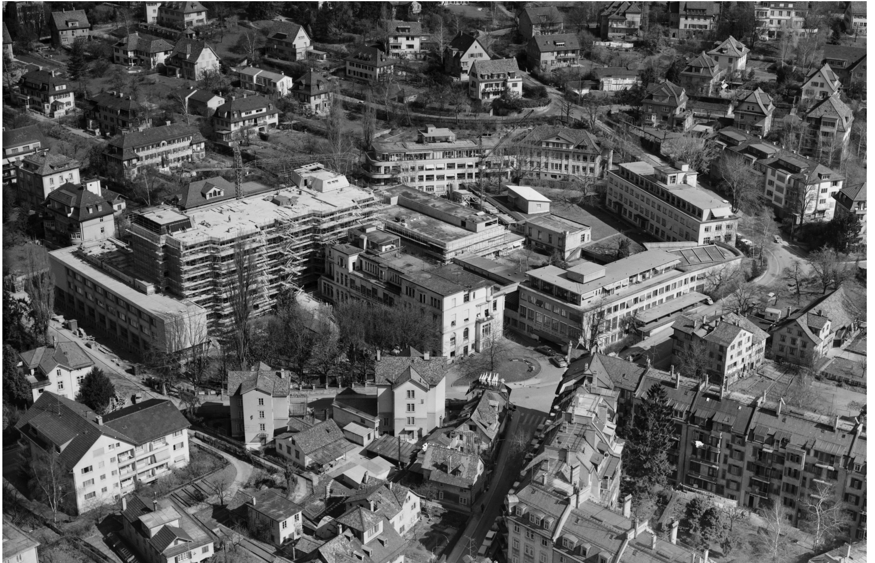
Abb. 17: Luftbild Errichtung der Steigerbauten, Quelle: Baugeschichtliches Archiv, 1966
