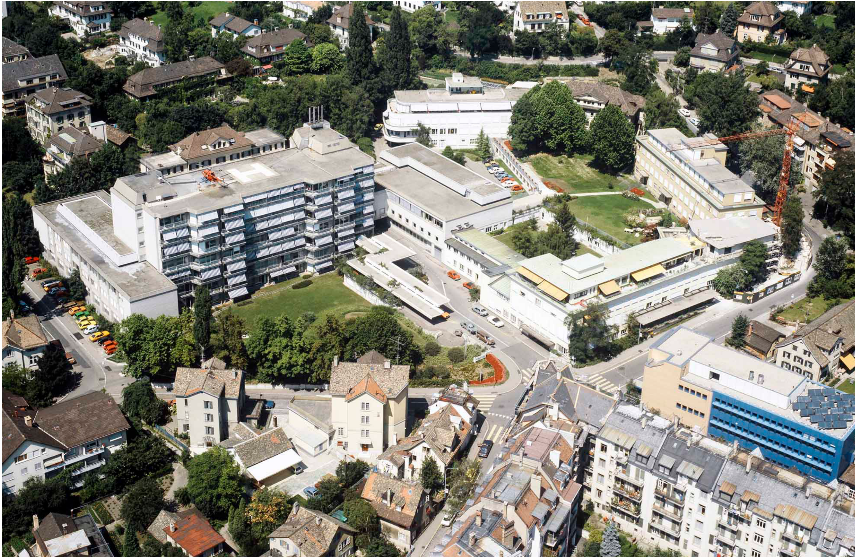
Abb. 24: Luftbild Kinderspital Areal Hottingen, Quelle: Baugeschichtliches Archiv, 1981
