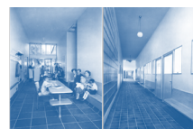
Abb.: Baugeschichtliches Archiv
